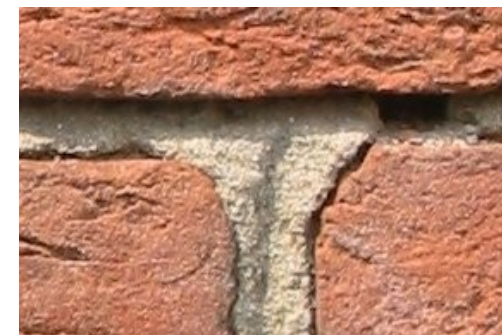
Argamassa entre tijolos
