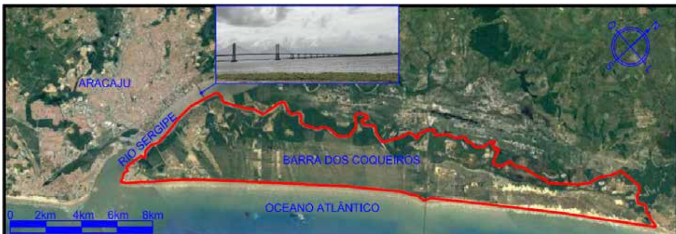
Figura 01 – Ligação através da ponte entre a capital Aracaju e o município de Barra dos Coqueiros
