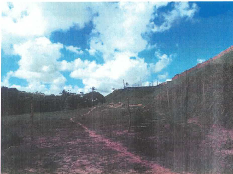
Figura 6 - Vista em solo do fundo do residencial, representando o início da entrada ao terreno
