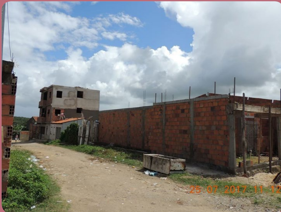
Figura 7: Casas em construção.
