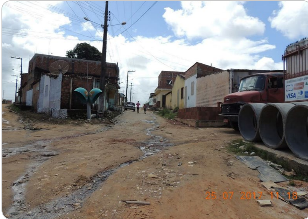
Figura 6: Ruas sem pavimentação.
