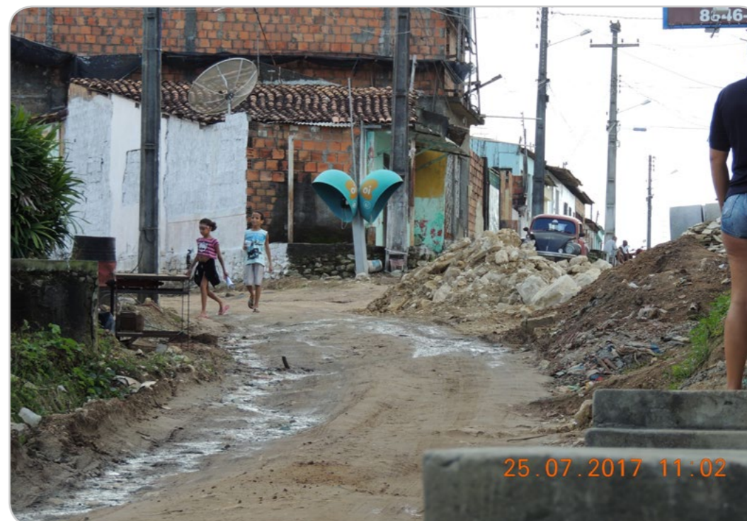
Figura 5: Ruas sem pavimentação.
