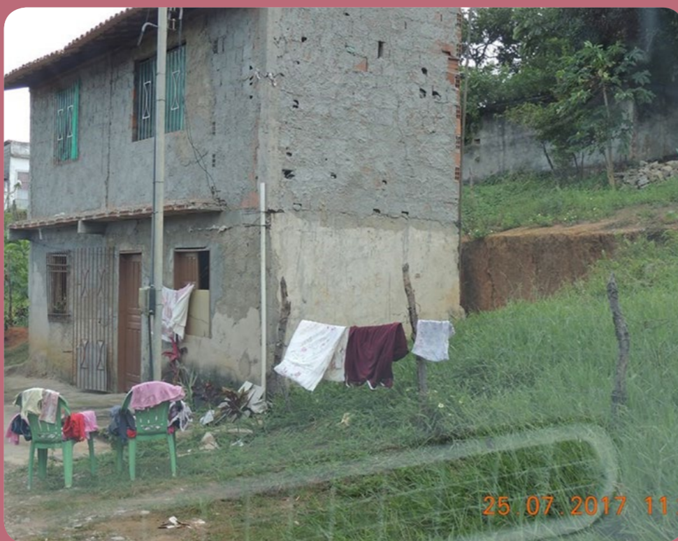
Figura 2: Casa construída em encosta removida pela ação humana.
